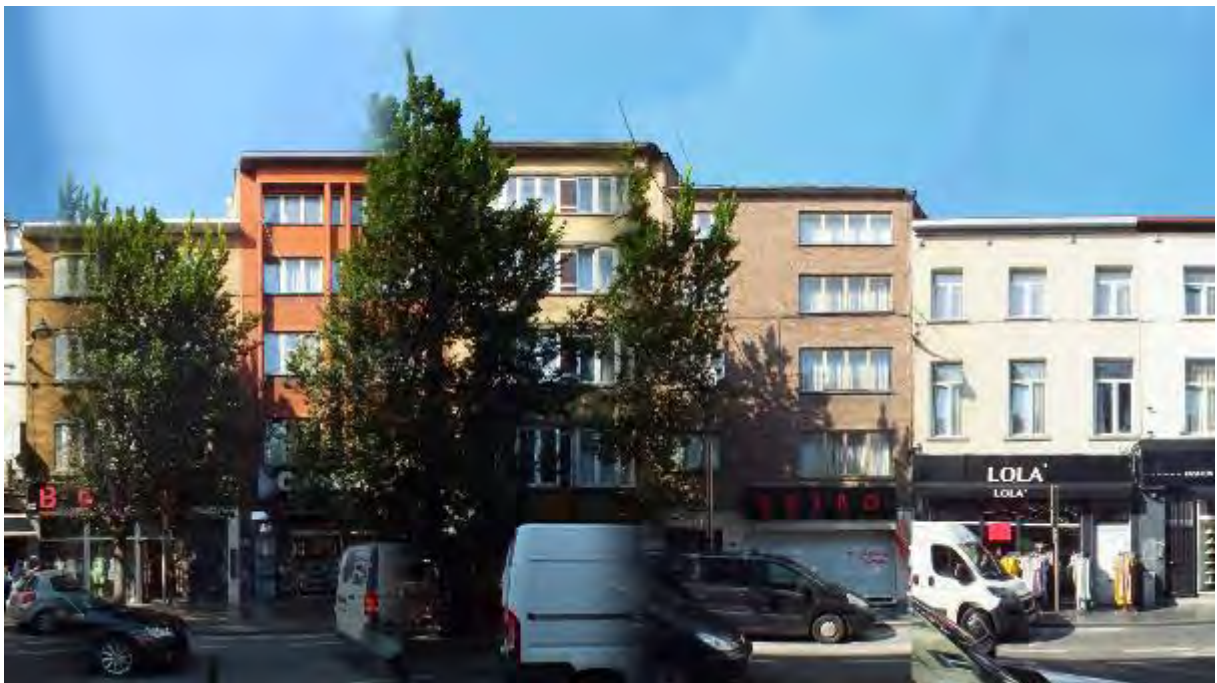
Fig.61 : Zoom sur la façade urbaine au niveau du champ d'observation de la caméra 3 au n° 17 de la Chaussée de Gand.
