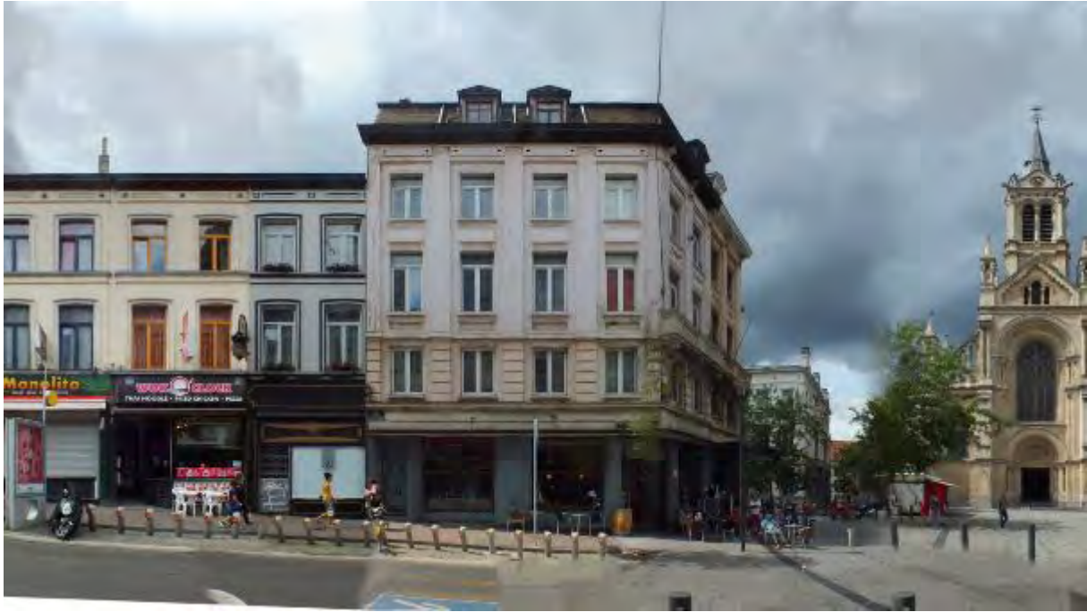
Fig.70 : Zoom sur la façade urbaine au niveau du champ d’observation de la caméra Bullet 3 au n° 121 de la Chaussée de Waterloo
