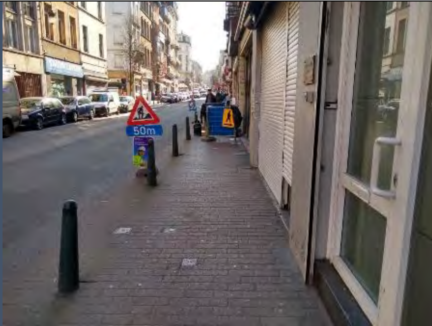
Fig.28 : Bollards et travaux sur la Chaussée de Waterloo, n° 19.
