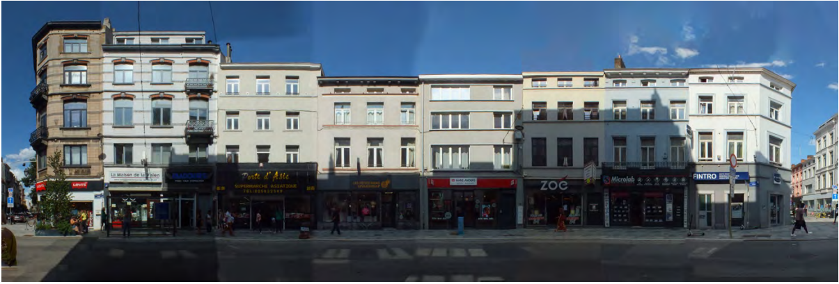
Fig.66 : Façade urbaine de la seconde caméra Bullet 4 au n° 122 de la chaussée d'Ixelles
