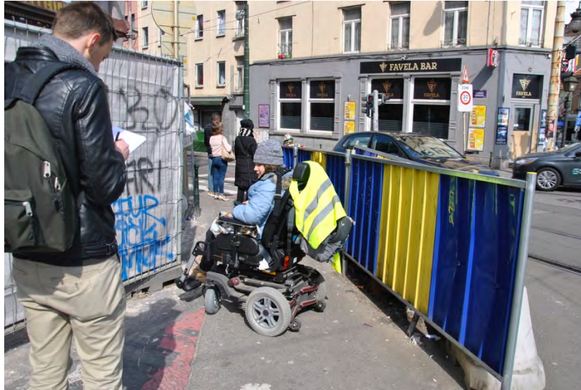
Fig.136 : Emprise des travaux et bordure problématique.
