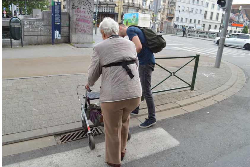
Fig.118 : Présence problématique d'un avaloir au milieu d'un passage pour piétons.
