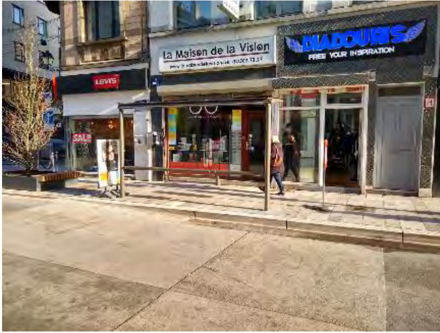
Fig.10 : Quais au niveau de l'arrêt de bus Quartier Boniface
