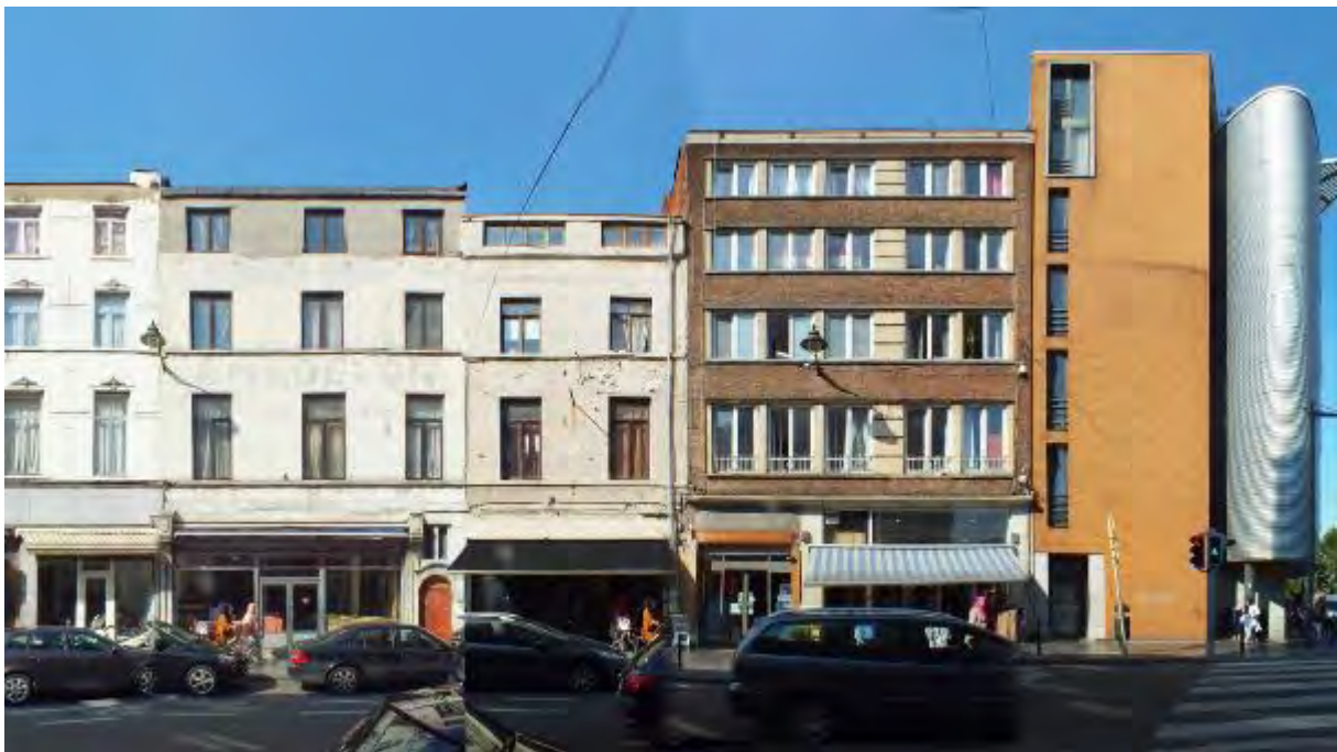
Fig.59 : Zoom sur la façade urbaine au niveau du champ d'observation de la caméra Bullet 3 au n° 1 de la Chaussée de Gand.
