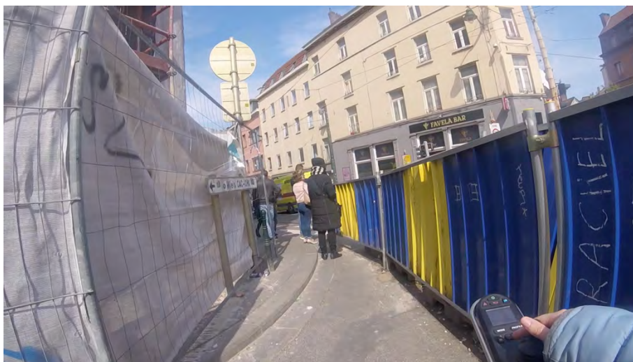
Fig.135 : Emprise des travaux et bordure problématique.
